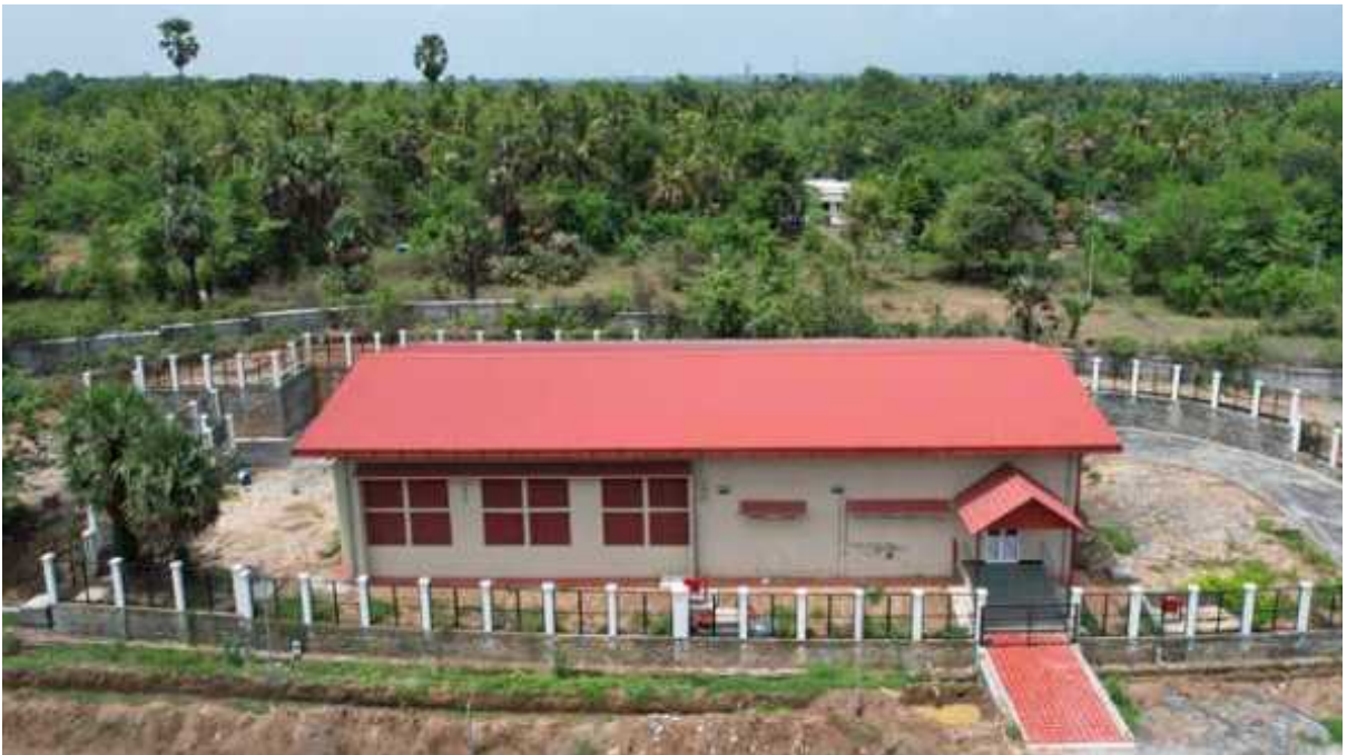
ठोस अपशिष्ट प्रबंधन भवन Solid Waste Management Building
